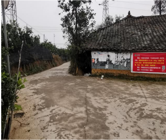
图 2.1-2 既有村道视距不良路段
