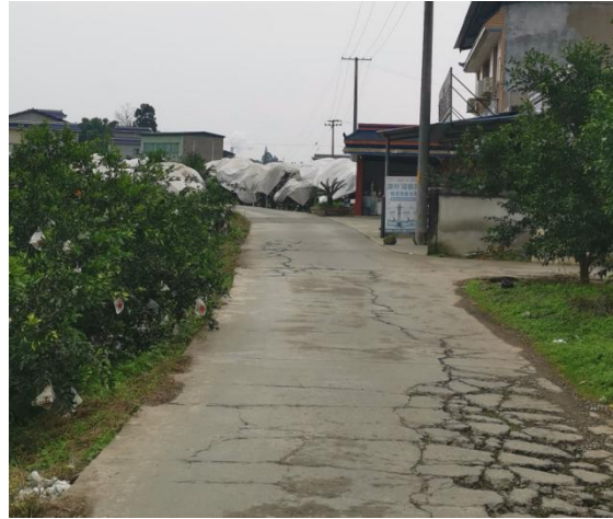
图 2.1-3 既有路基、路面现状
