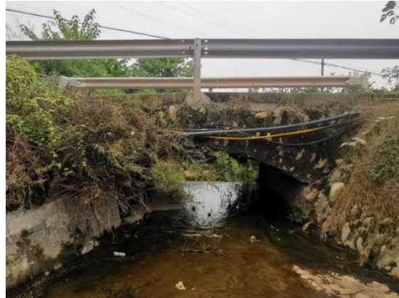
图 2.1-7 沿线既有涵洞照片（二）
